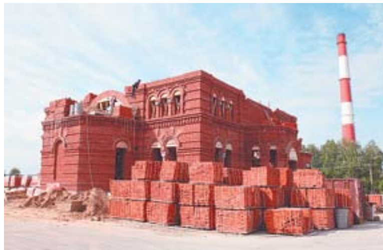
Вновь возведенные стены храма Святой Троицы
